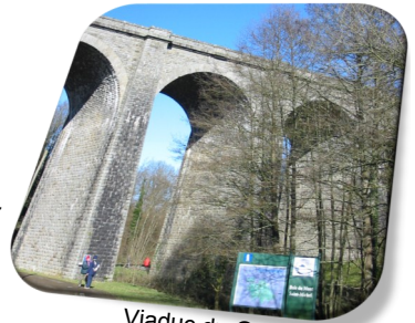
Viaduc du Guibel
